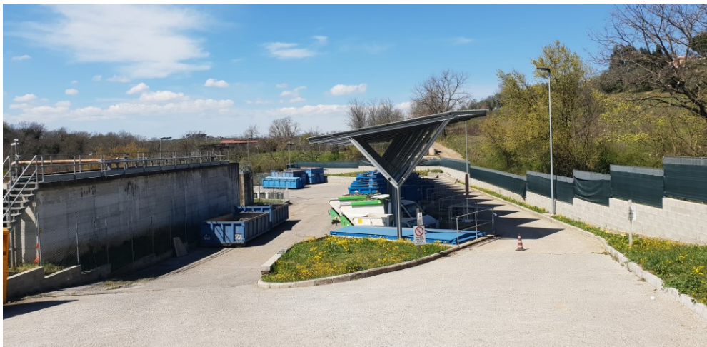
Foto 3 - Veduta del Centro di Raccolta di Mazzano
